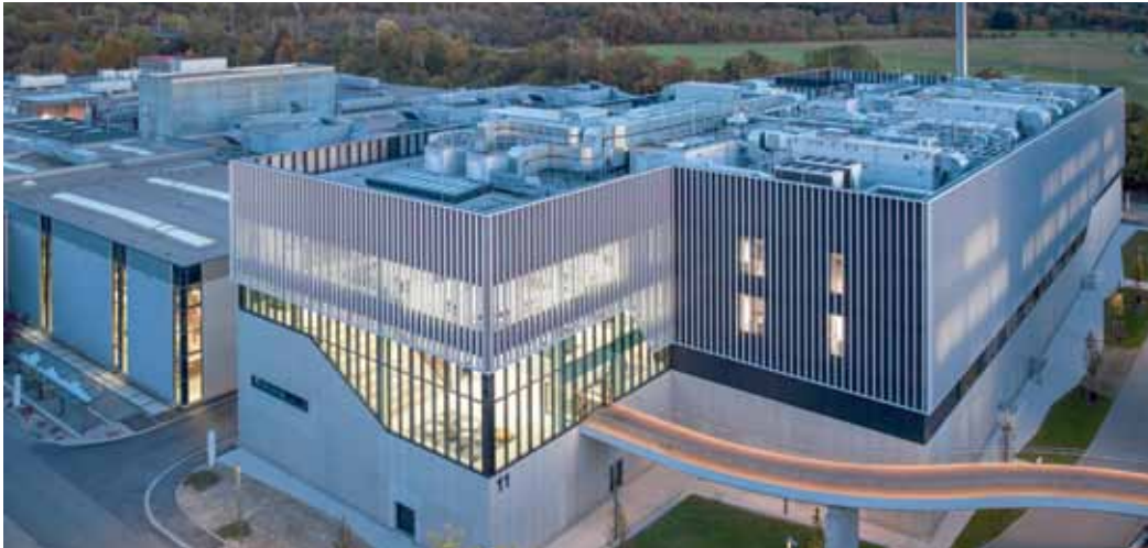
Das neue Hilti Innovationszentrum für Brandschutz und Verbunddübel in Kaufering vereint architektonisch die unterschiedlichen Nutzungsarten in einem klaren, funktional-modernen Human-Centered Design.
